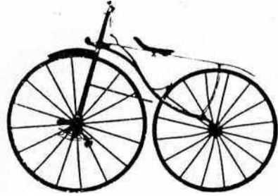
Bouchage Velocipede fra Lyon, med forhjuls affjedring ved hjælp af fjedertråd.
